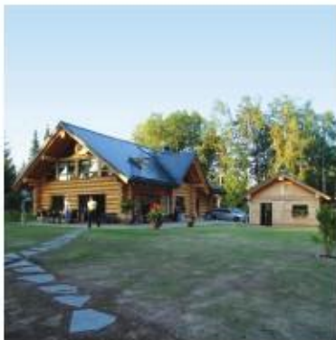
Opvarmning af annektsbygninger
